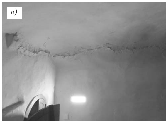
Рис. 2. Деформування несучих елементів Церкви Різдва Христового:
