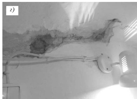
Рис. 2. Деформування несучих елементів Церкви Різдва Христового:
